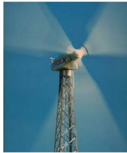
Figure I-4 : Mâts en treillis.
