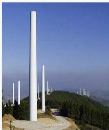
Figure I-3 : Mâts tubulaire d'un parc éolien
