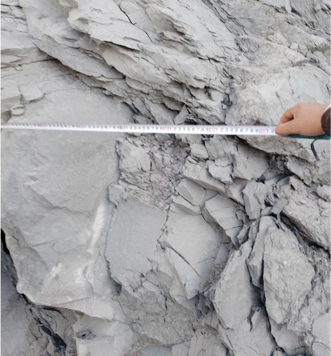
Fig.30 : Mesures d'espacement entre discontinuités in-situ
