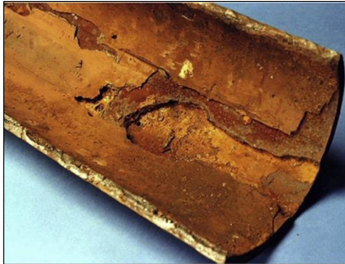
Figure I.10 Corrosion interne dans un oléoduc de pétrole brut [32]
