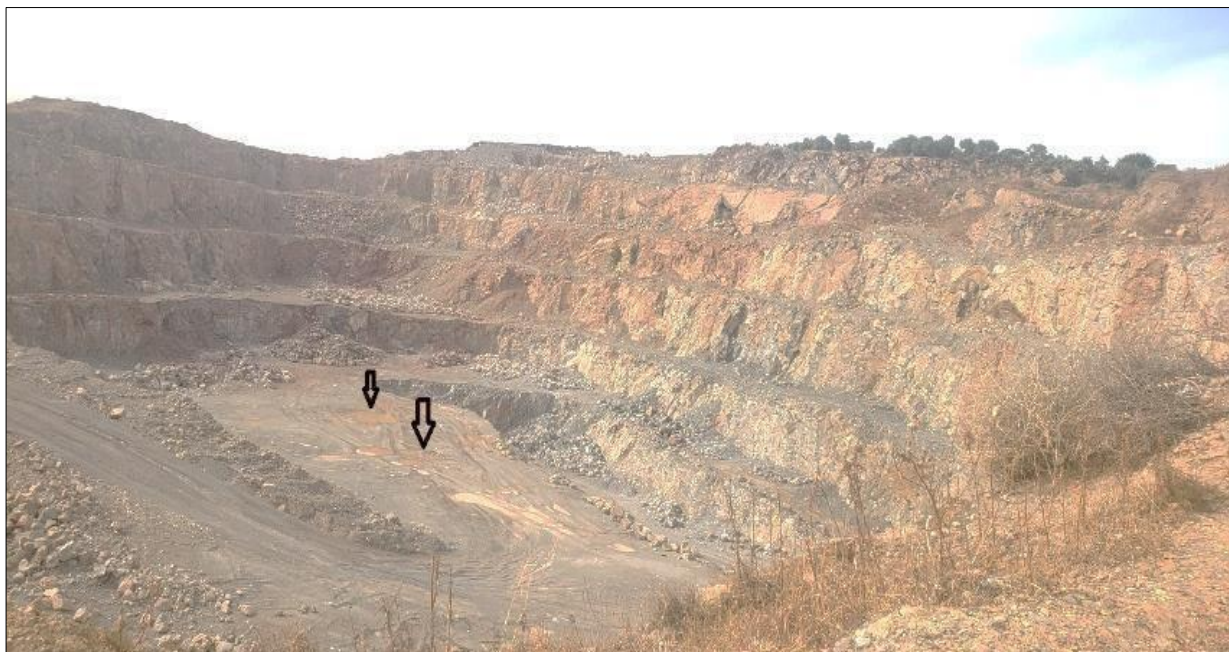
Figure 20 - L'eau de pluie s'accumule au fond de la carrière de granulats Héliopolis, formant des mares
