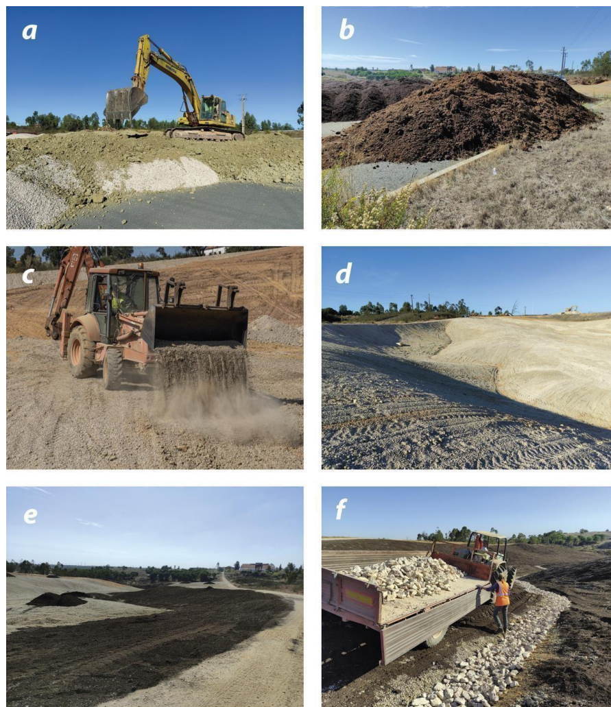
Figure 24 -Mettre en œuvre des procédures de couverture du sol et de remédiation du DMA (Sánchez Donoso et al., 2023).
