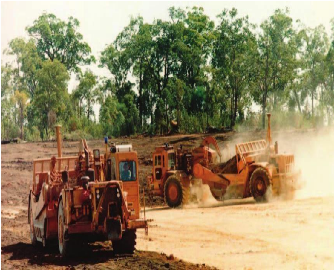
Figure 28 -Les scrapers remettent en place la terre arable (Koch J. M, 2007)
