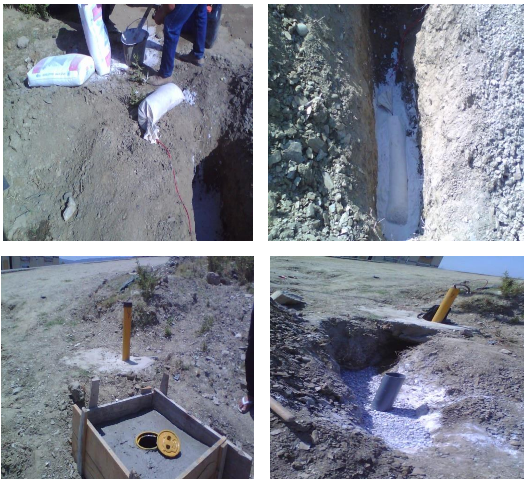
Figure I.26. Principe de pose d'une anode sacrificielle (Skikda 2017).
