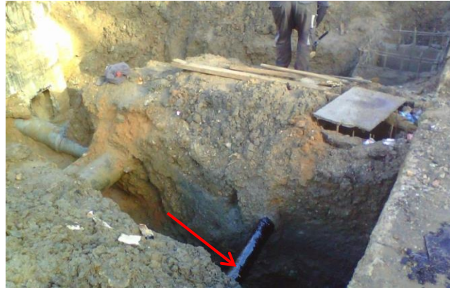
Figure I.18. Revêtement type C à chaud (Photo réelle à Skikda).
