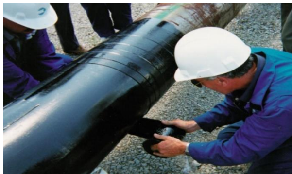
Figure I.19. Revêtements par bande adhésive).
