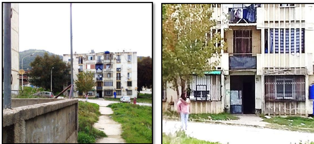
Figure 11: Cité 700 logements (Plaine Ouest) (Photo Personnelle).
