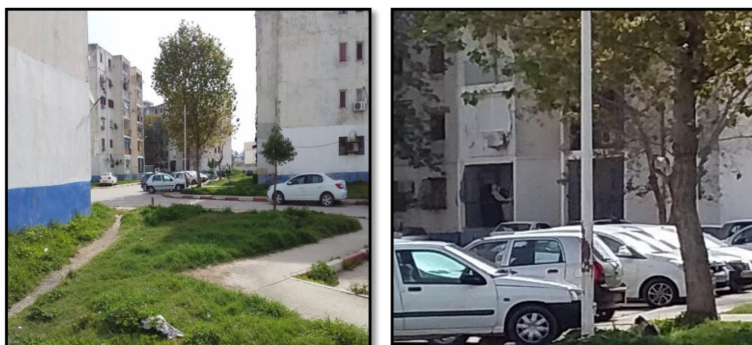
Figure 16: Cité 100 logements (Plaine Ouest) (Photo Personnelle).
