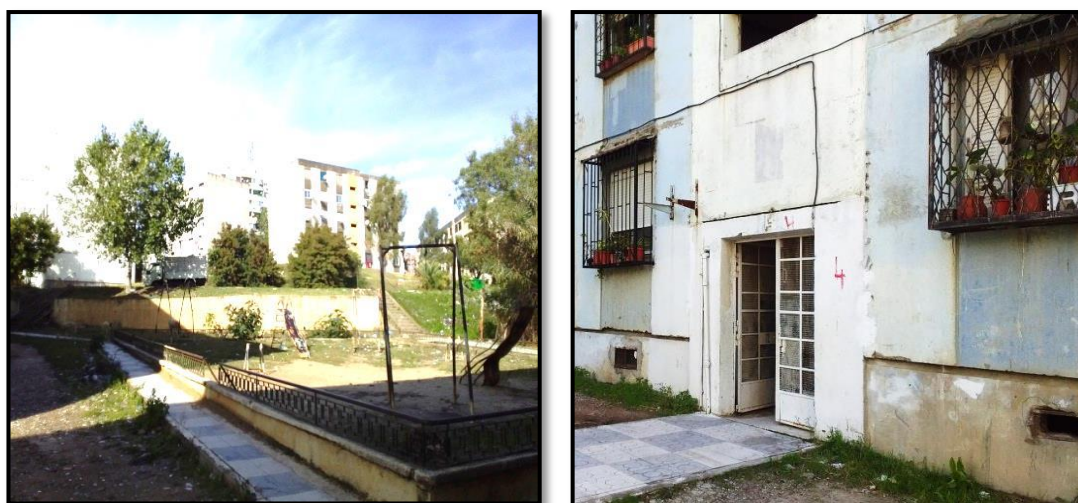
Figure 13: Cité 116 logements (Plaine Ouest) (Photo Personnelle).
