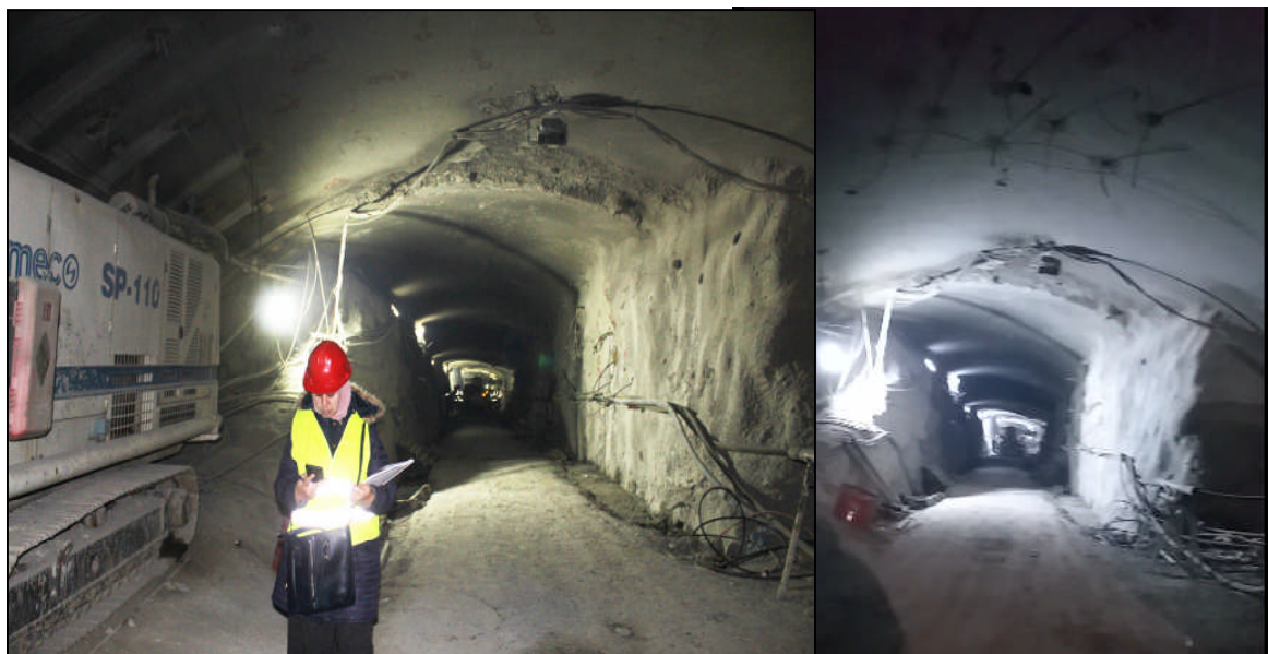
Figure IV.8 : confortement de la zone endommagée de l'effondrement au niveau du tube droit par le remplissage en béton massif (butée en béton)
