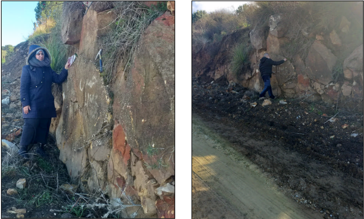
Figure V.23 : le miroir de faille dans les formations gréseuses
