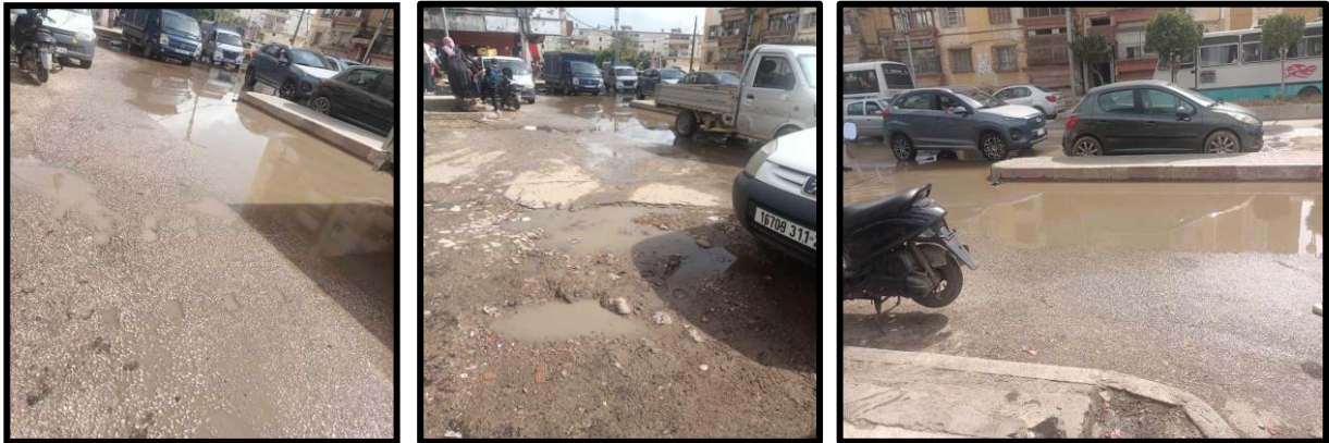
Photo n°05 : voiries de contournement on mauvais état.
