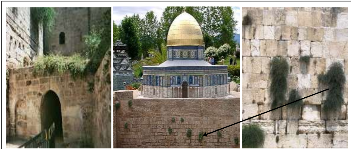
Fig. 11. Câpriers manifestement suspendus et régénérés depuis des siècles sur le mur de soutènement de la mosquée d'El Aqsa (au centre et à droite) et sur le toit du tunnel Kotel Hakalan.
