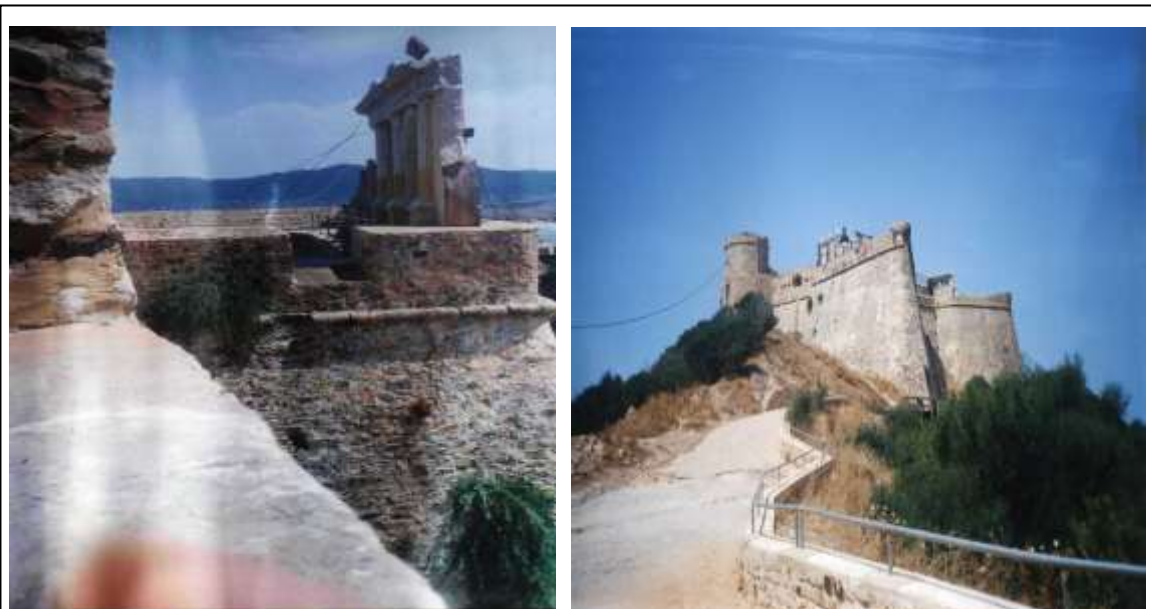
Fig. 10. Câprier sur les façades exposées au soleil du mur antique (Fort Génois) Tabarka Tunisie –Aout. Clichés : Benseghir (2005) b
