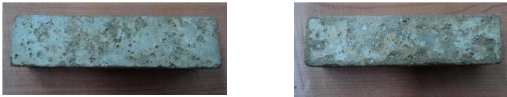
Figure IV.52- Dégradation visuelle des bétons de sable à base avec laitier granulé conservés dans le MgSO_4
