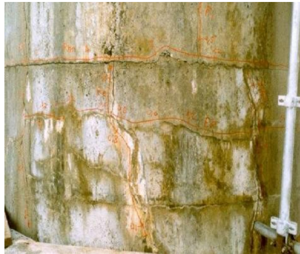
Figure I.20- Attaque sulfatique interne [LCPC]
