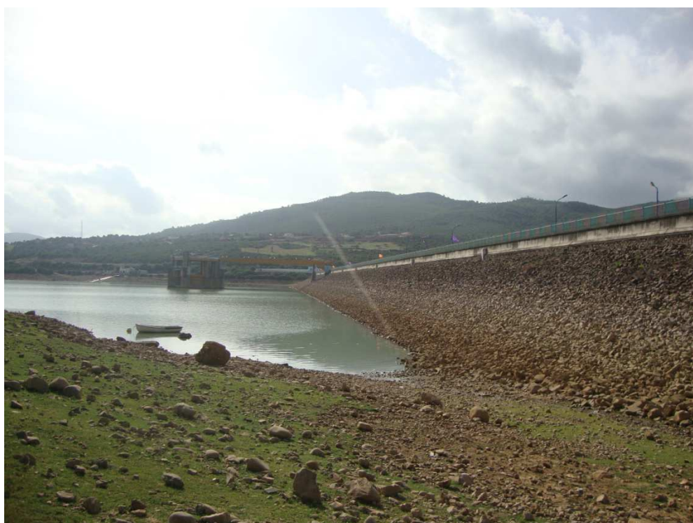
Photo 1. Site d'échantillonnage au niveau du réservoir Cheffia (photo prise le 13.10.2014, BENREDJEM Lamia).
