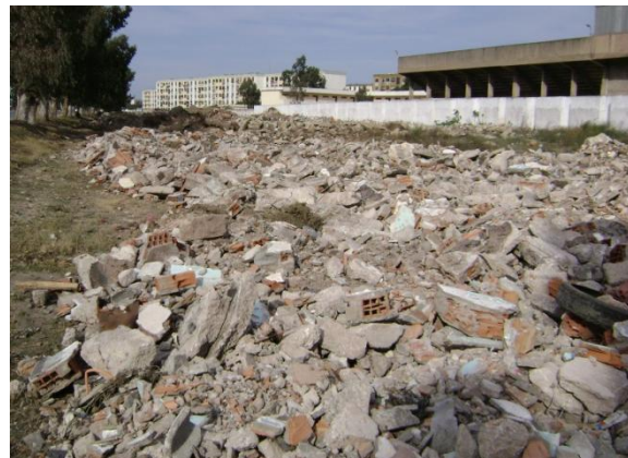
Débris mixte de bétons et maçonnerie
