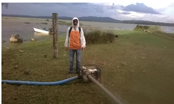
(c) Pompage de l'eau du lac pour l'irrigation
