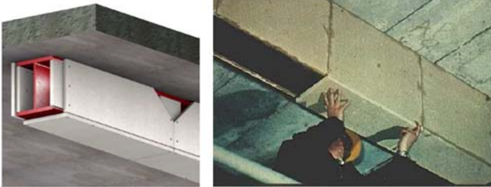
Figure 5. Protection de l'acier avec des plaques isolantes
