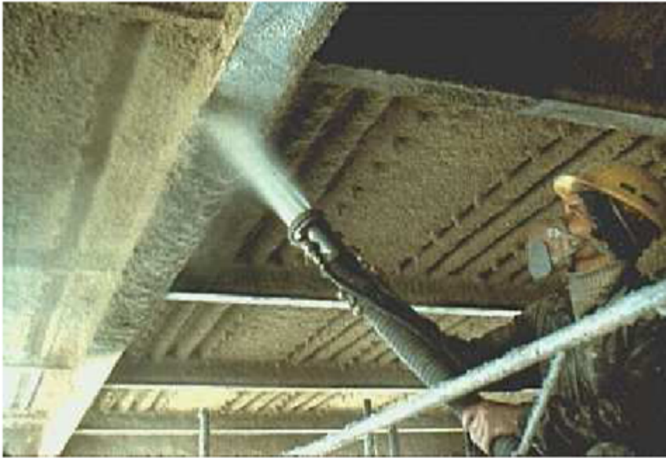
Figure 4. Protection de l'acier avec du mortier projeté
