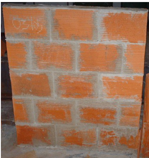
Fig. IV.65 Mur 8 trous sans enduit n°2.
