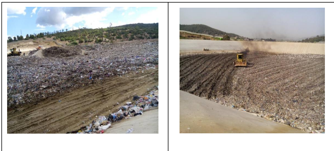
Figure 27: Opération d'enfouissement au CET de BerkaZerga
