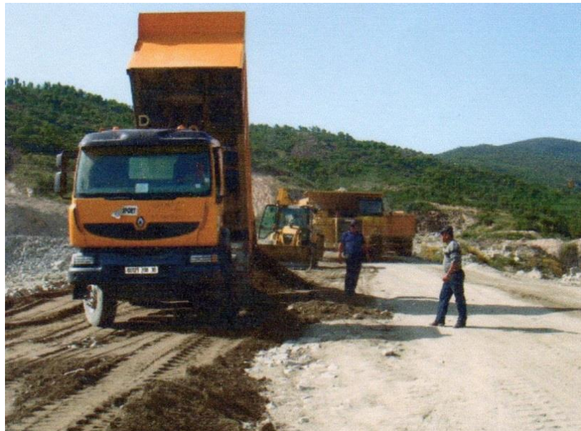
Figure 27 : Ouverture des accès (OHL-Infrarail 2010)
