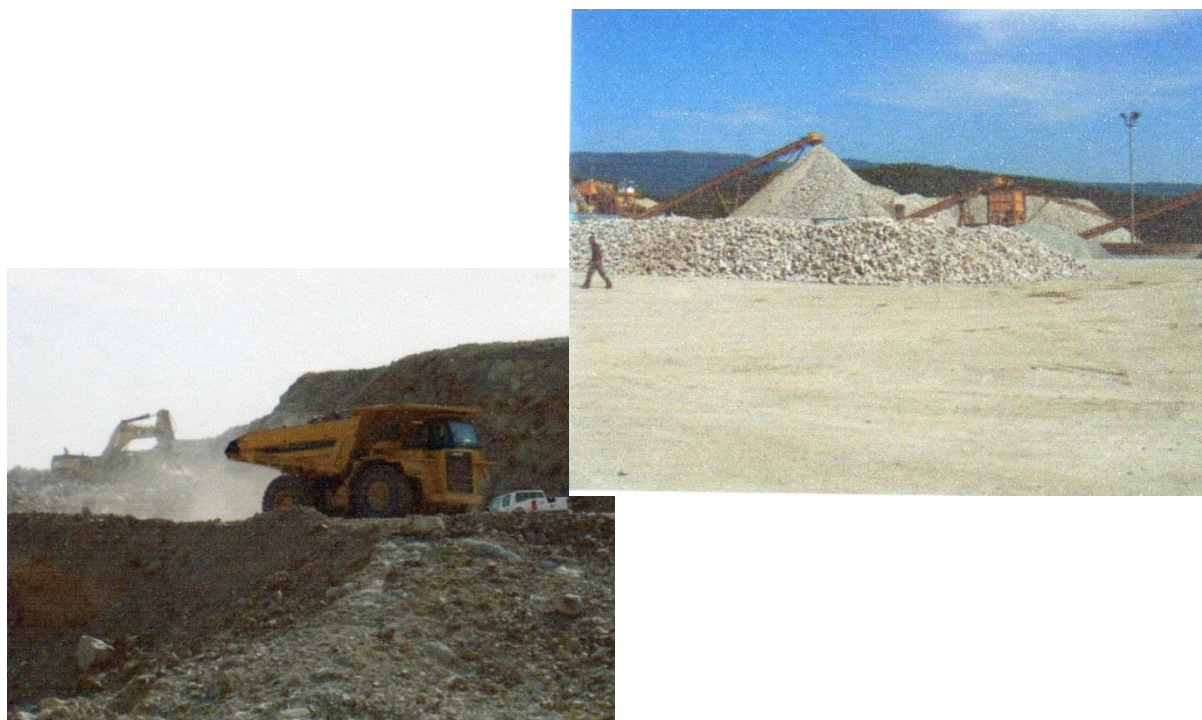
Figure 30 : Chargement de la charge abattue, Dumper de carrière 25t (Ohl-Infrarail 2010)
