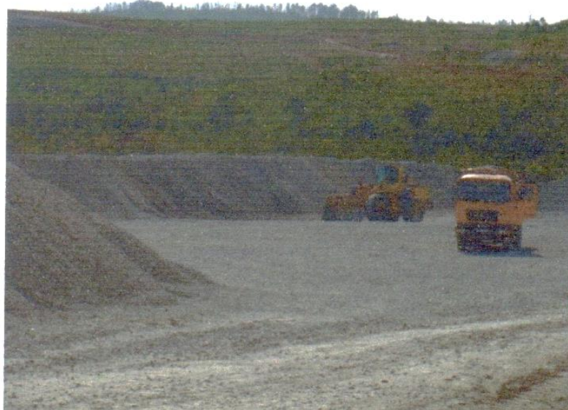
Figure 32 : Camions pour le transport et pont bascule (OHL-Infrarail 2010)
