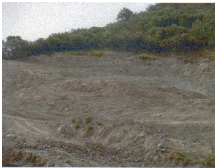
Figure 26 : Déboisement des terrains et aménagement des pistes (OHL-Infrarail 2010)
