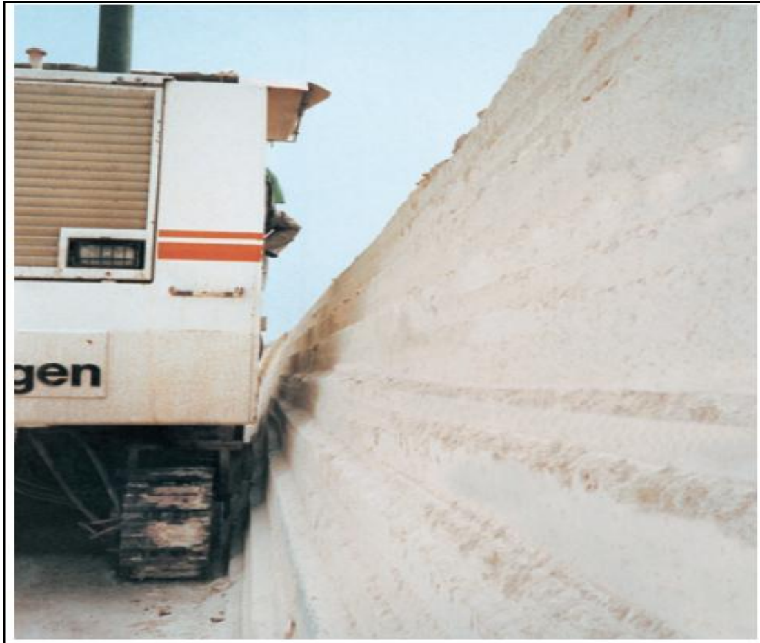
Fig.3.12. Taille de grands talus en pente raide
