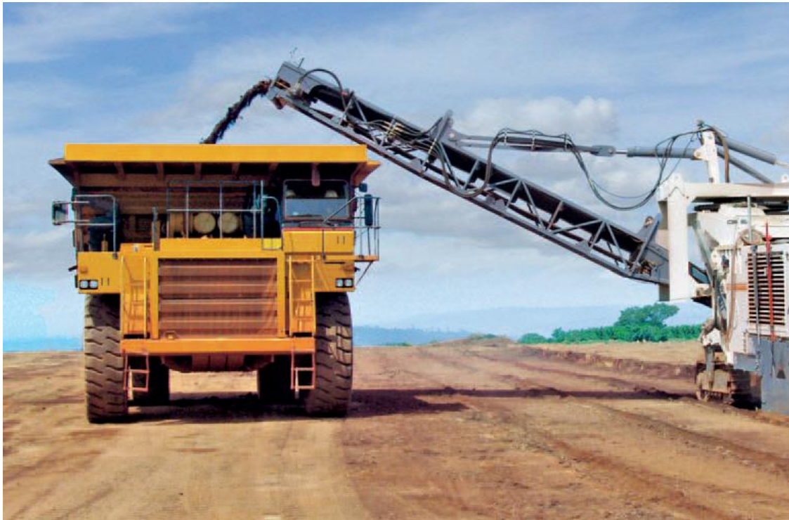
Fig.3.13. Chargement direct (Chargement sur le camion)
