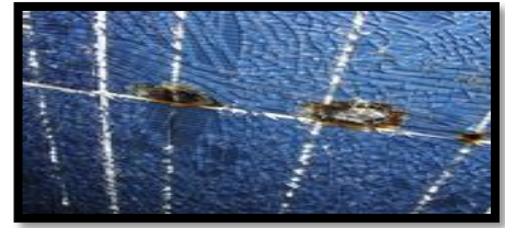
Figure I. 19 Défaut de points chauds.
