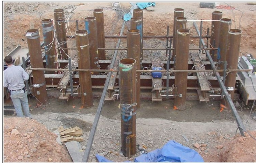
Fig. I- 20: Groupe de pieux et pieu isolé.
