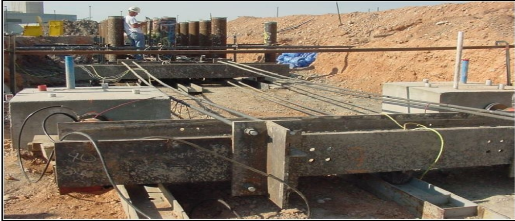
Fig. I- 19: Dispositif de chargement (2 vérin + poutre de réaction + barres).
