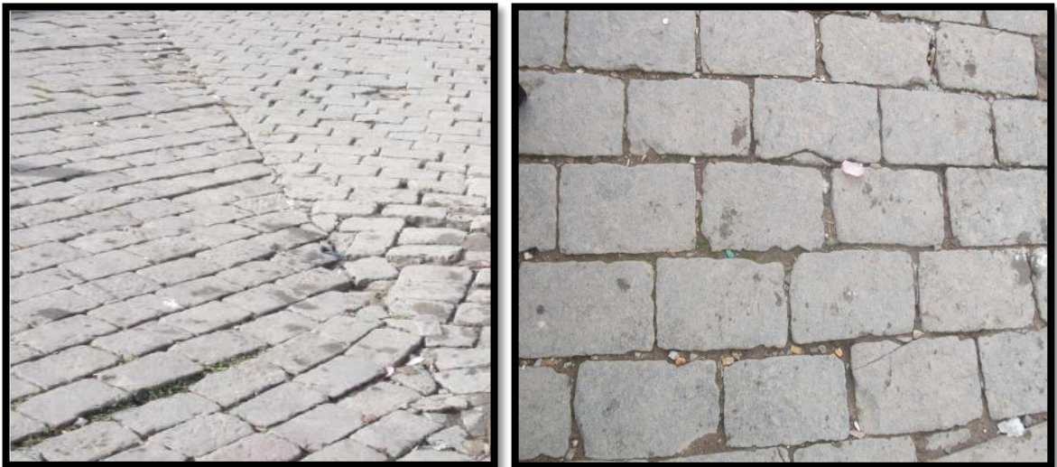
Fig.67 : Le pavé de la place de Sidi Djeliss. Source : Auteur, décembre 2014
