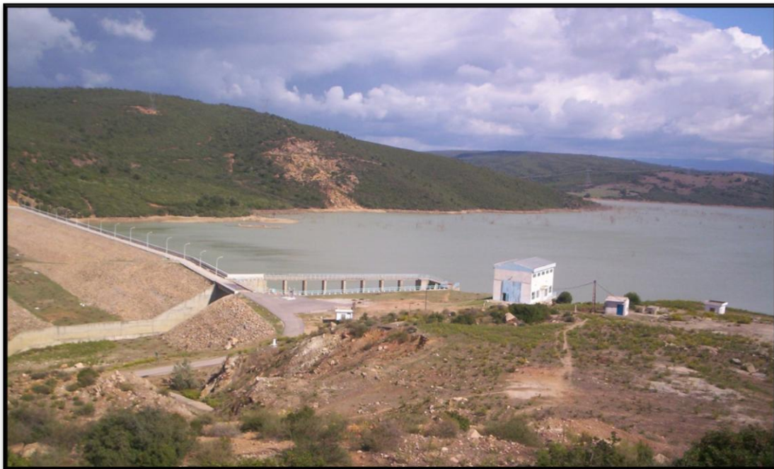
Fig (3) : Digue, tour de prise et évacuateur de crue de la retenue Mexanna.
