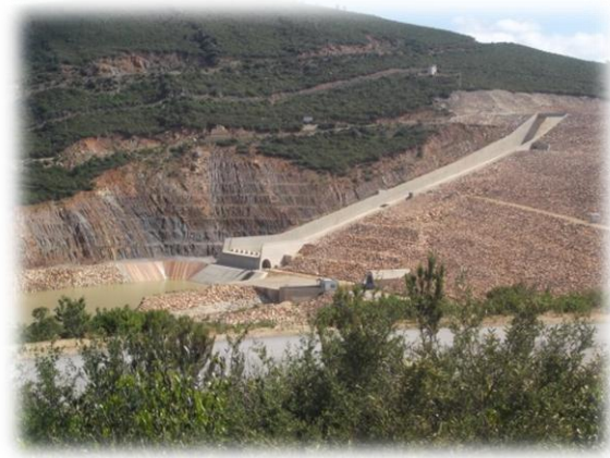
Fig.32. Évacuateur bétonné de Barrage Bougous
