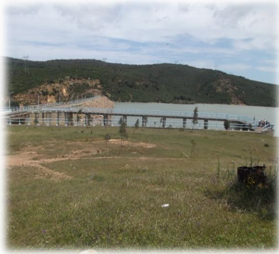
Fig.29. Barrage de Mexa
