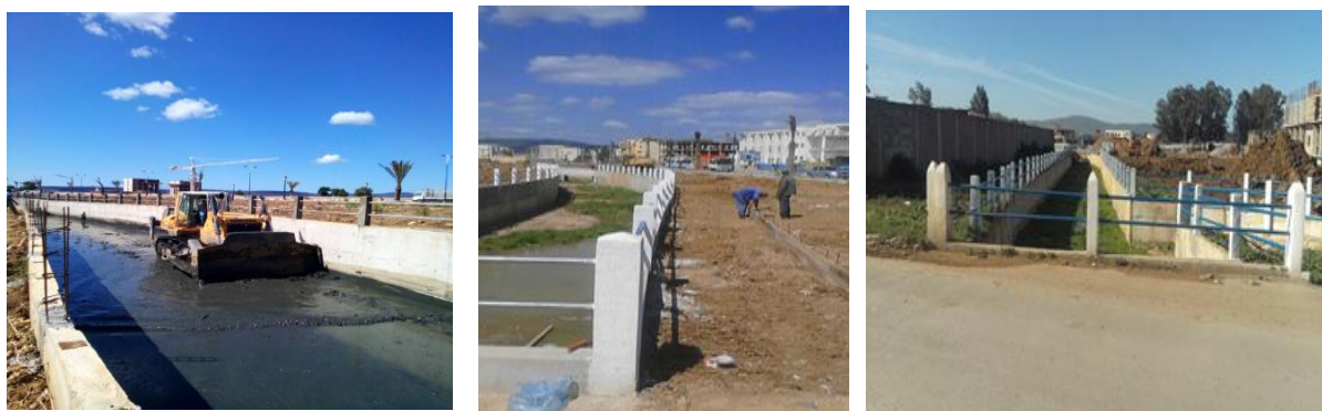
Fig.53. Achèvement des travaux
