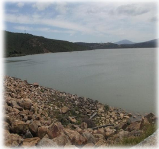
Fig.30. La digue de barrage à matériaux Locaux
