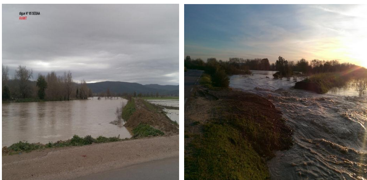
Fig.64. Digue N° 05 Sebaa
