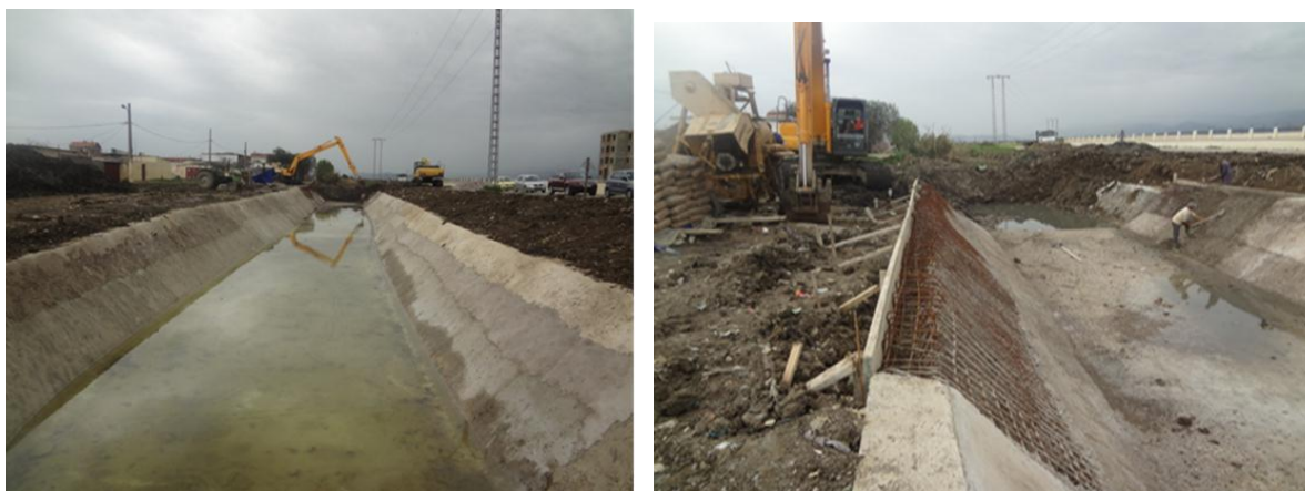
Fig.50. Travaux D'aménagement Du Canal De BEN AMAR-
