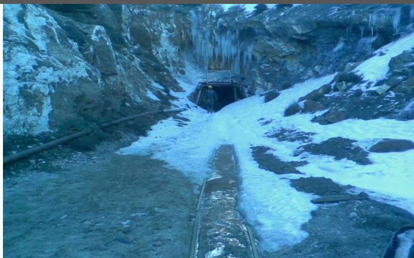
Fig. 12 : L'entrée d'une mine souterraine (mine de Barytine Ain Mimoun, Algérie)
