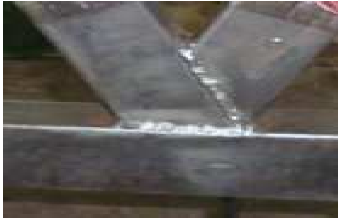
Fig.6.15 Nœud près de l'appui
