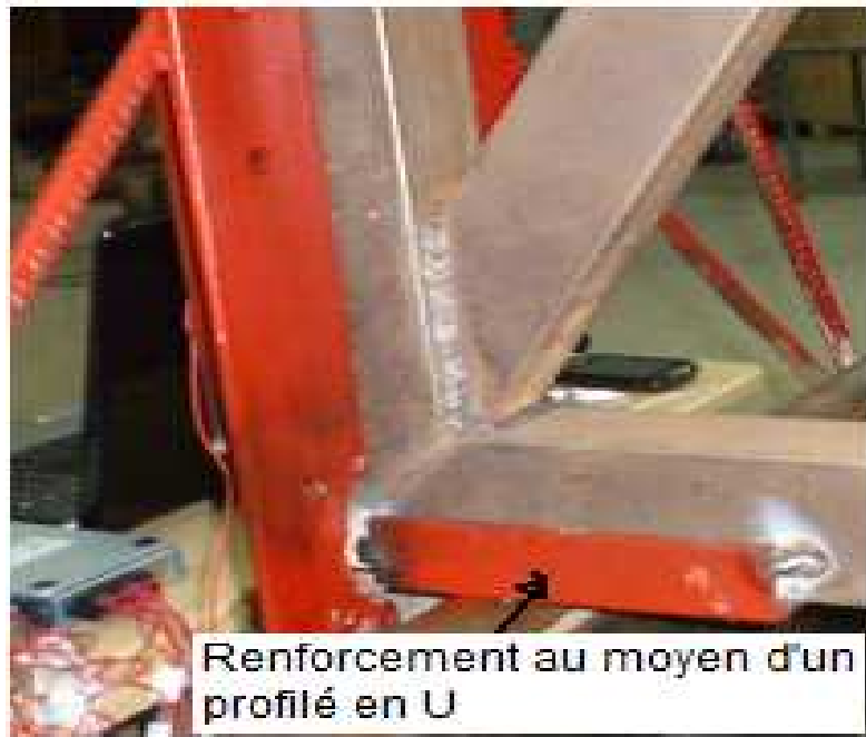
Figure 4.12 : Renforcement de la poutre au niveau de l'appui.
