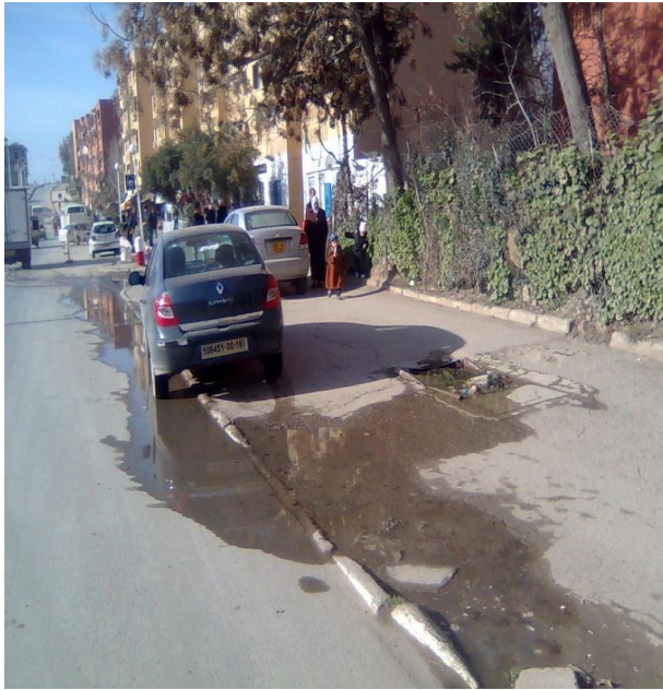
Photo 4.5. Fuites d'eau sur la conduite de distribution de la Cité 1700 logements
