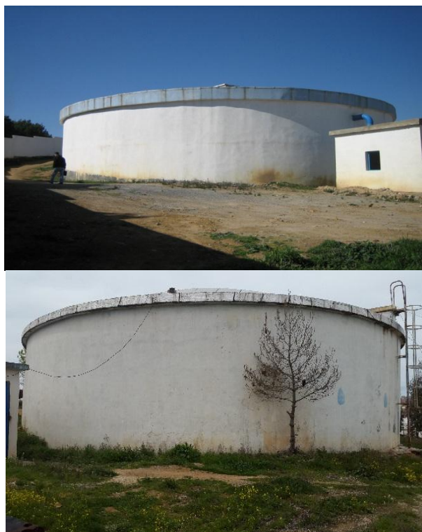
Photo 4.4. Réservoir 26 Avril (BCEOM, 2009)
