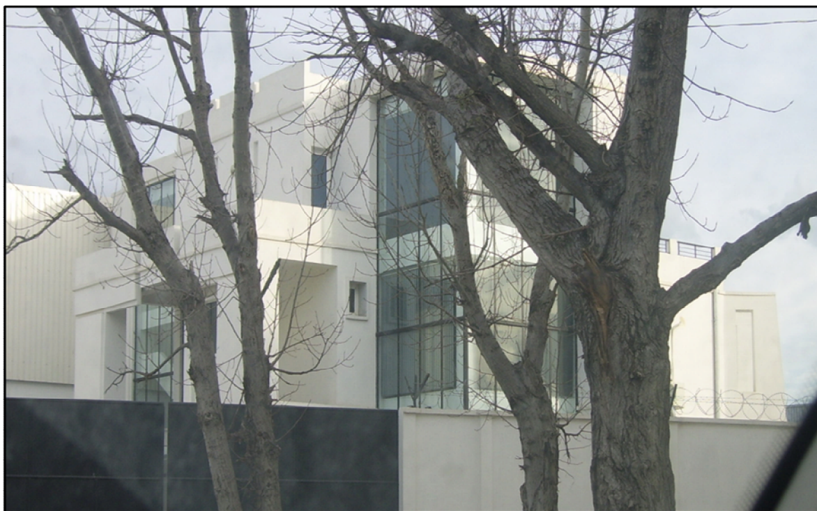
Un nouveau souci pour une qualité architecturale ZAC MIN unité de production des électroménagers RAYLAN
