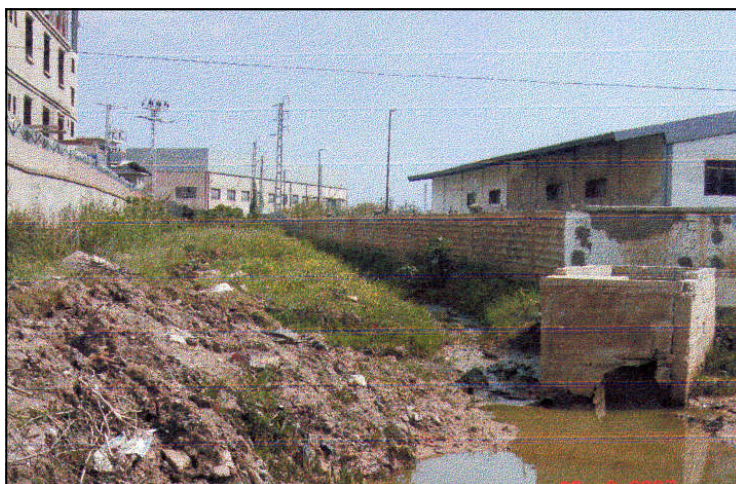
Photo 49 bis stagnation des eaux pluviales EL ALLALICK
