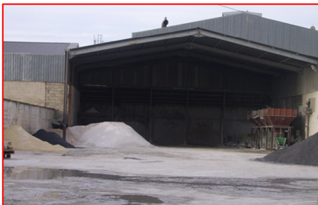
Photo.16 type de Hangar métallique isolé en pente
