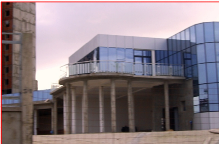
Photo 46 une station de service en cours de construction ZAC EL BOUNI sur l'autre coté de la RN16 où un nouveau style architectural est utilisé (une structure légère, des murs rideaux, une forme développée.) C'est une source d'inspiration pour influencer les nouvelles constructions dans la zone d'EL ALLALICK
