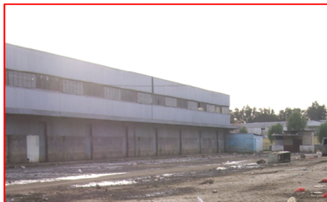
Photo. 17 Hangar avec une structure mixte et une toiture métallique plate
