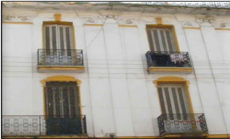
Photo n° 63: Tracé permettant de comparer la forme du trumeau de celle de la baie ; dans ce cas le trumeau est large comme une baie et demi, spécimen 4 ilots 9.
