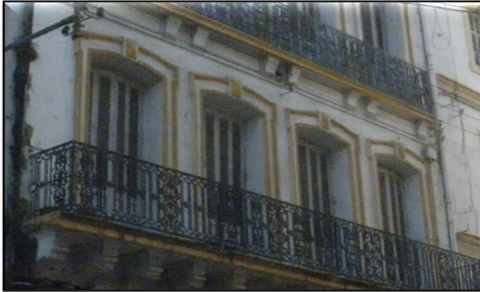
Photo n° 62 : Tracé permettant de comparer la forme du trumeau de celle de la baie ; dans ce cas le trumeau est large comme la demi baie.
