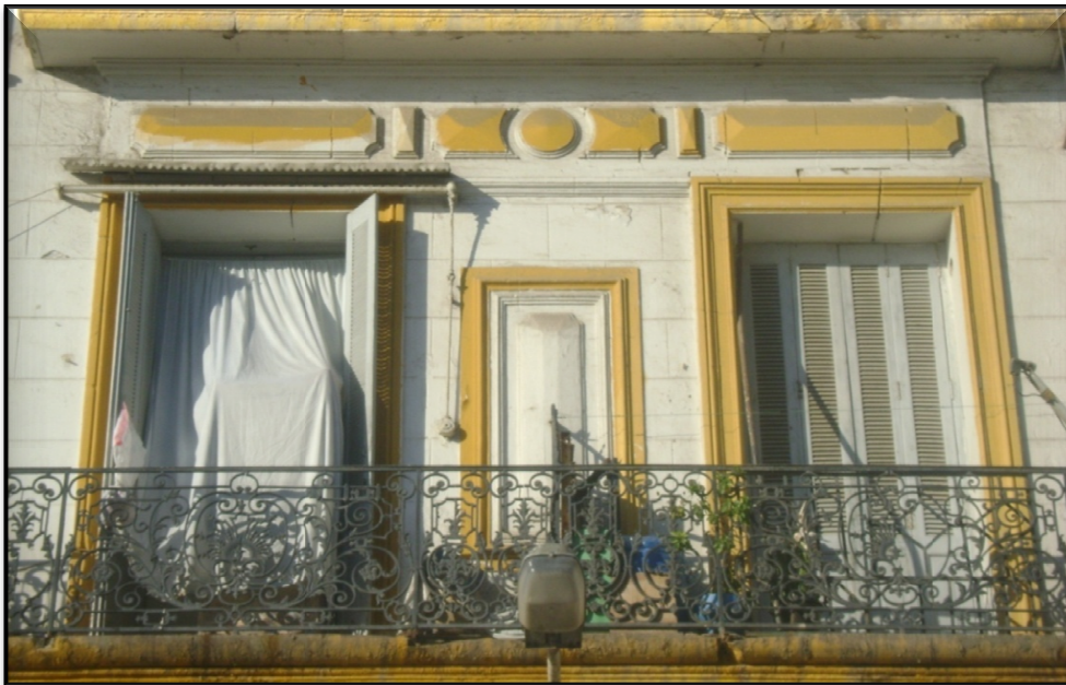
Photo n°61: Tracé permettant de comparé la forme du trumeau de celle de la baie ; dans ce cas le trumeau a la même largeur que la baie, Source : Auteur 2009.
