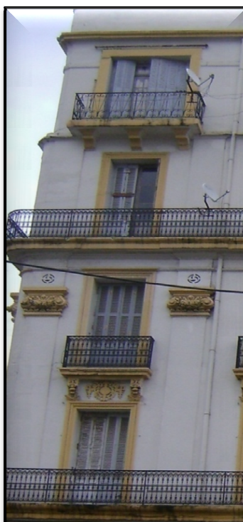
Photos n°84: Spécimens à 4 étages, structure par le balcon, à 3 segment BBbB. Source : Auteur 2009.
