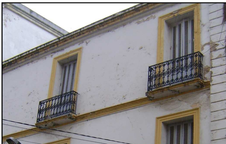
Photo n° 64: Spécimen n°734 ilot 10, trumeau large comme deux fois la largeur de la baie, Source : Auteur, 2009.
