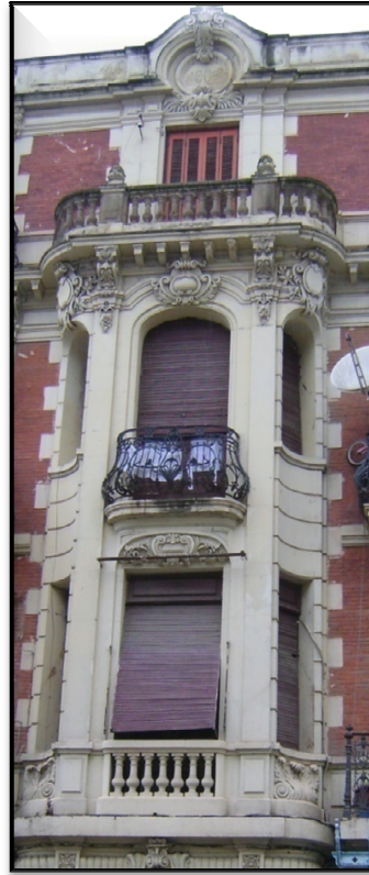
Photo n° 81 Spécimens à trois étages, structure par colonnade, à 2 segments CCB. Source : Auteur 2009.
