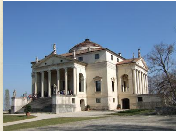
Figure 114 : Vue extérieure de la villa Palladio. Page | 80
