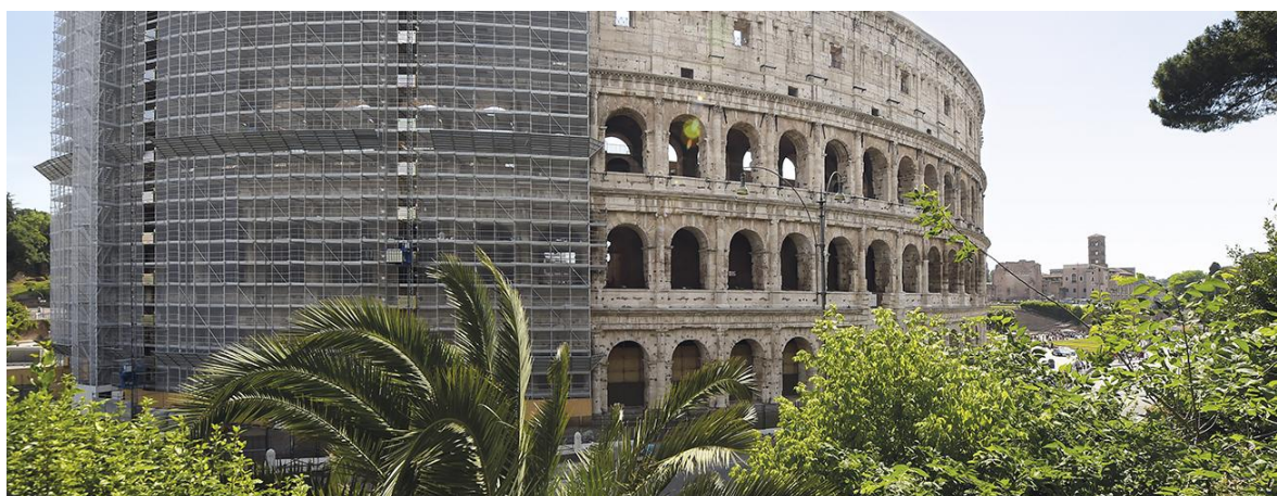
Figure 124 : Le colisée à Rome pendant la première phase de sa restauration.
