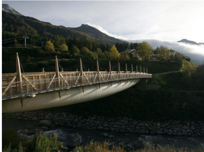
Figure 34 : Le pont de Val Cenis.
