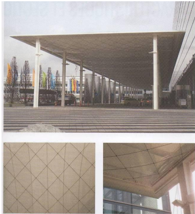
Figure 35 : Toiture en coussins gonflables à l'aéroport de Munich, Allemagne.
