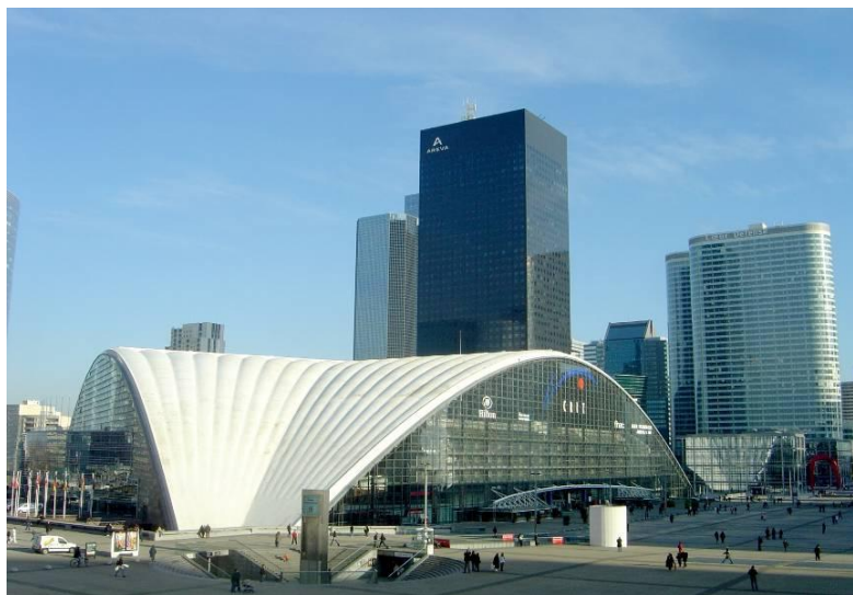
Figure 44 : Les voûtes en éventail du CNIT à Paris.
