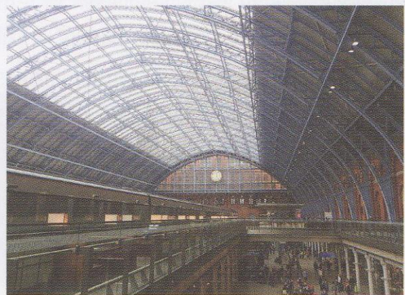
Figure 37 : Le hall d'arrivée des trains Eurostar dans la gare Saint Pancras de Londres, d'une portée de 73 mètres.
