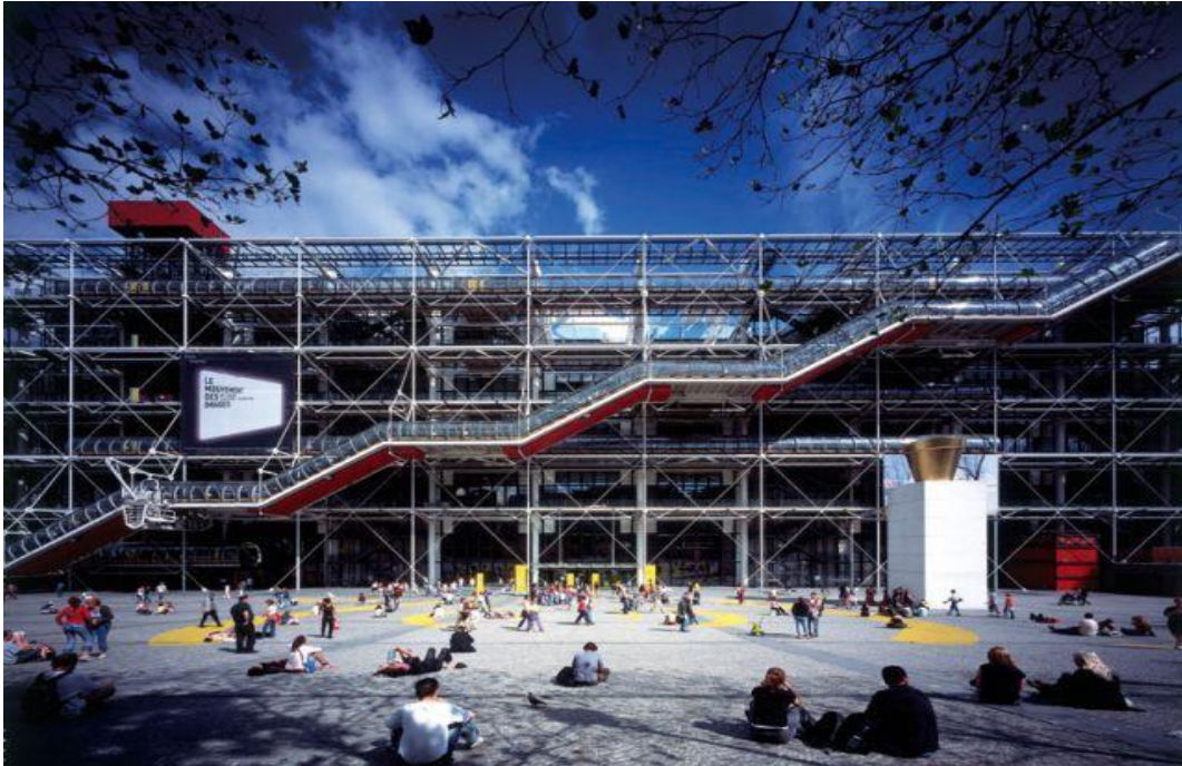
Figure 136 : Façade du centre national d'art et de culture George Pompidou.
