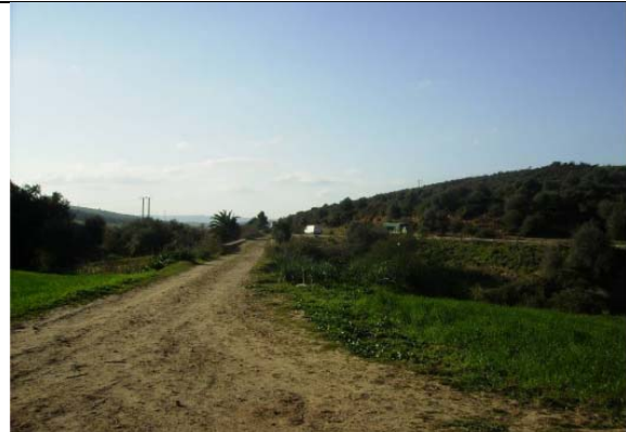
Photo : Début du viaduc sur oued Guessaba.
