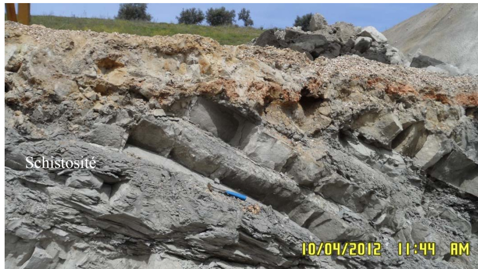
Photo 27 : Schistosité des formations argileuses observées à la sortie du premier tunnel (Bouche 2)
