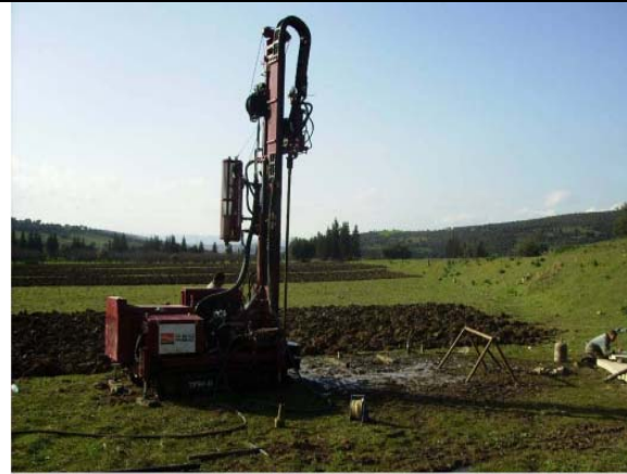
Photo : Fin du viaduc argiles alluvionnaires de Guessaba.
