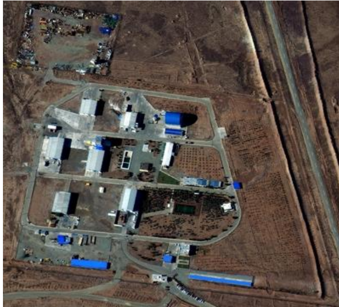
a. La base avant l'explosion
