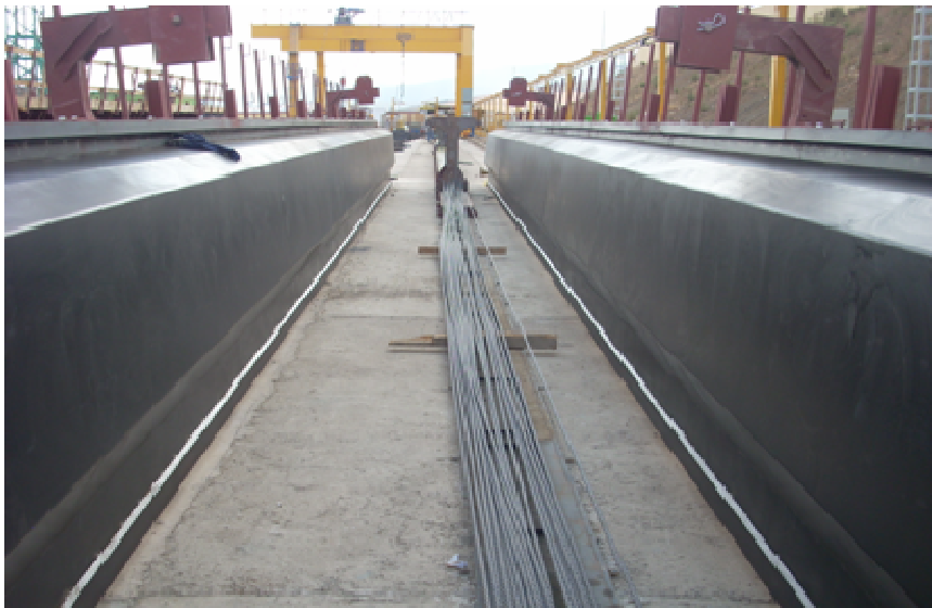
Figure 1.4 : Fabrication des poutres précontrainte en série (chantier COJAAL El Taref).
