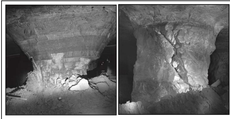
Figure I.8 : Deux piliers rompus photographiés dans des carrières de calcaire américaines par Esterhuizen et al (2011).
