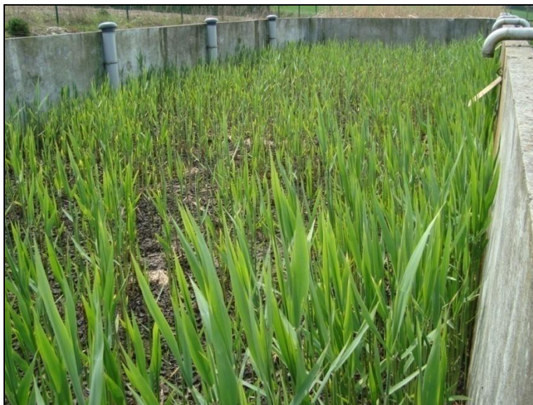
Figure N°11 : Lits de séchages plantés de roseaux [50].
