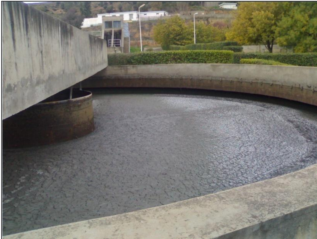
Figure N°25 : Epaississement des boues [23].
