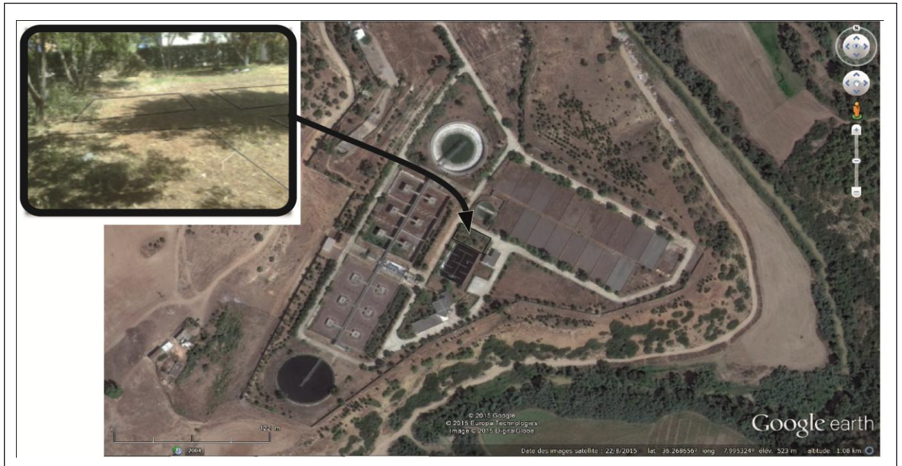
Figure N°40 : Localisation du terrain d'essai dans l'enceinte de la STEP de la ville de Souk Ahras [194]
