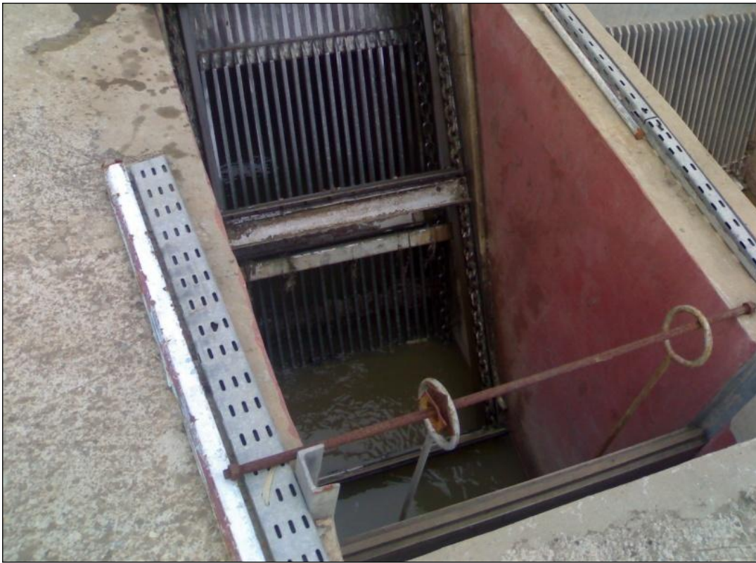
Figure N° 21 : Dégrillages grossiers [23].
