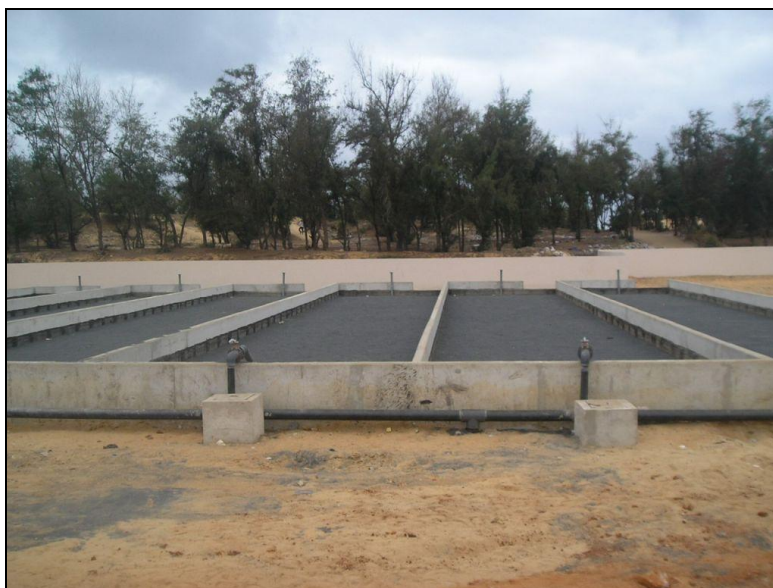
Figure N°10 : Lits de séchages (non plantés) [23].
