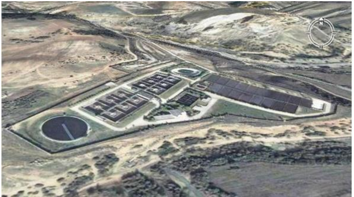
Figure N°19 : Image satellite de la station d'épuration des eaux usées Souk Ahras[23].
