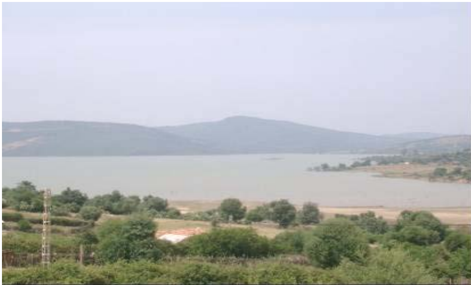
Fig.3.9. Vue d'Ouest du barrage Mexa.
