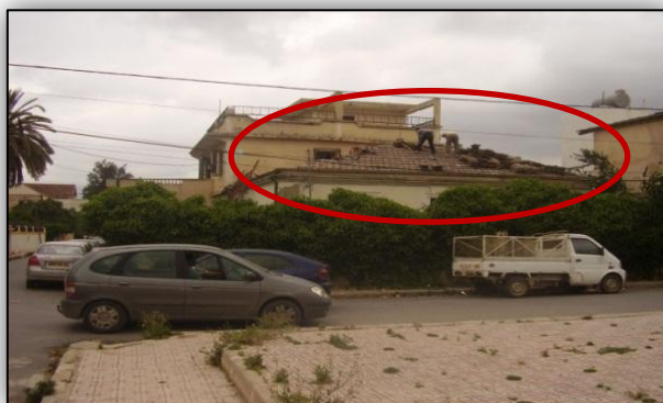
Figure n 102: Les travaux de réfection de la toiture
