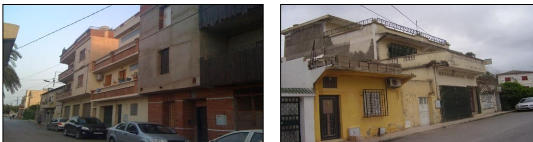
Photos n 79.80: La suppression des clôtures et des espaces libres privés de façade
