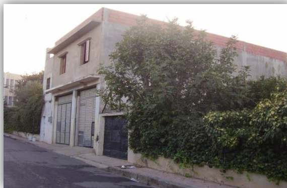
Photo n 108:Construction avec un CES de 100%
