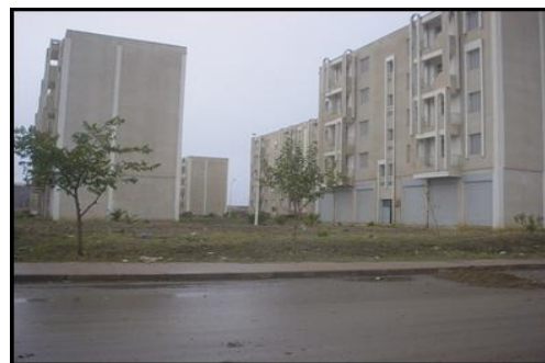
Photo n 50: La cité frères REHABI
