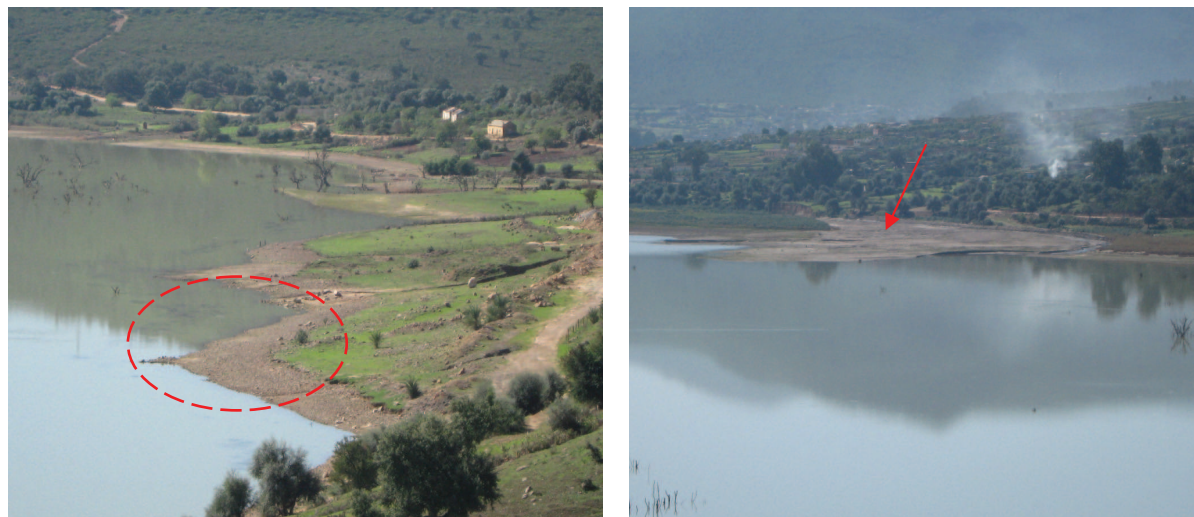
Photo 7. Dépôts de vase dans le barrage : Sur la rive gauche (photo à gauche) et dépôts de vase à l'entrée de l'Oued Bougous au barrage (photo à droite).
