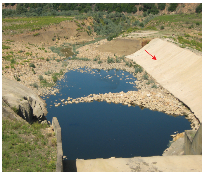
Photo 6. Opération de bétonnage des berges en aval du barrage de Mexa.
