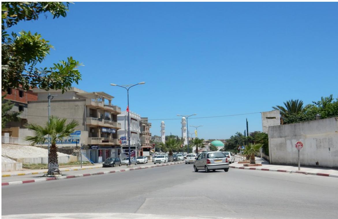
Figure 22 : Premier segment du tronçon choisi du boulevard "1 er Novembre"
