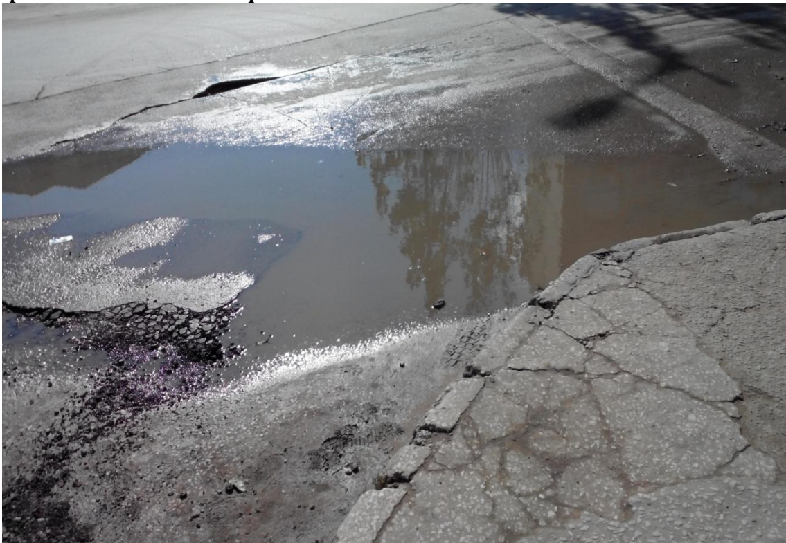
Figure 117 : La dégradation et le manque d'entretien de la chaussée, une source de gêne pour la circulation mécanique
