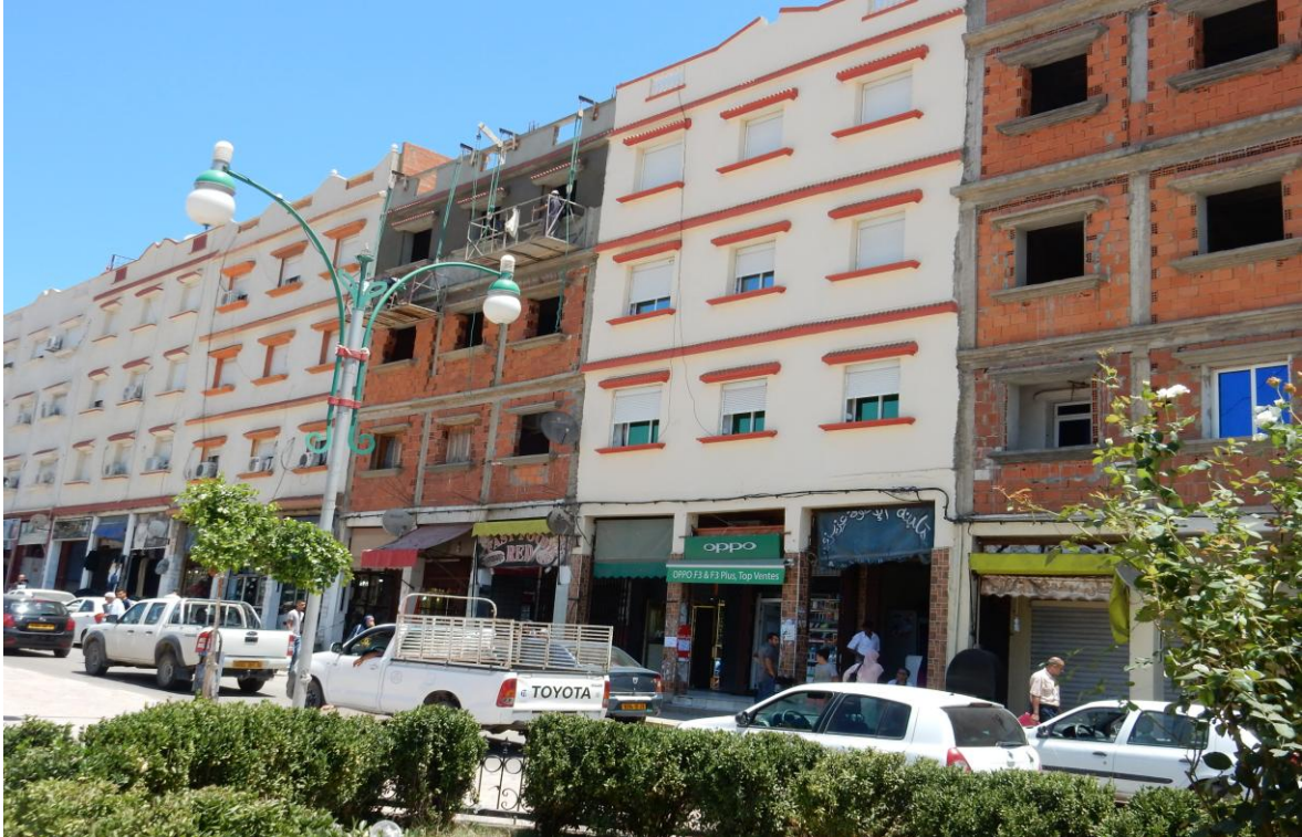
Figure 36 : Des façades dénuées de détails bordant "la place publique d'El Bouni-centre"
