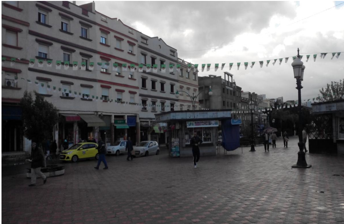
Figure 16 : Les lotissements "Braadia 1" et "Braadia 2" après l'opération de démolition-reconstruction
