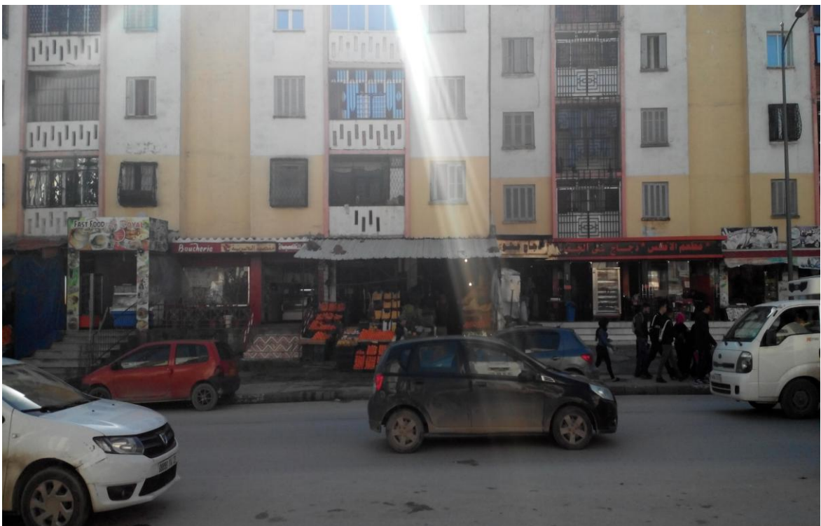
Figure 25 : Une façade avec de nombreuses portes
