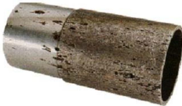
Figure I.7: Corrosion par piqûres d'un acier inoxydable [54].
