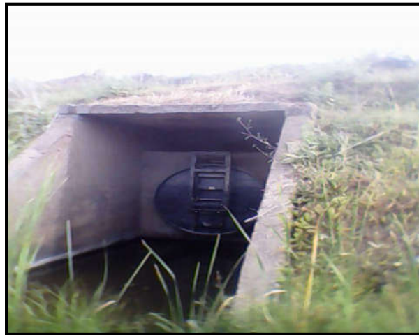
Figure II.11 Ouvrage de rejet, passage busé sous digue muni d'une vanne à clapet circulaire ( \text{Ø}1500\text{mm} ), (photo prise en 2017)
