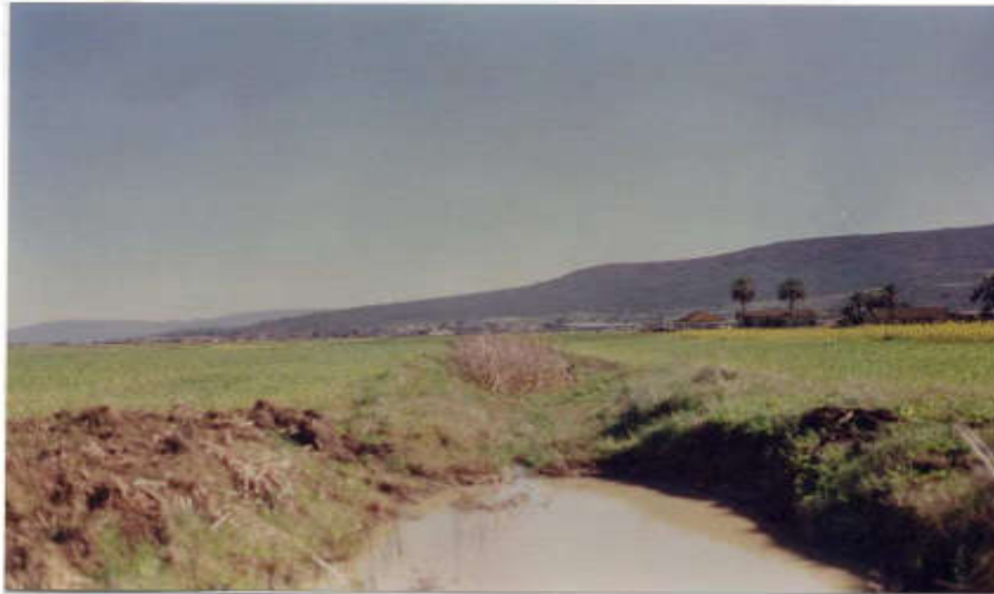
Figure V.12 Canal D 05 mal entretenu bloquant l'écoulement de l'eau
