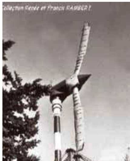
Fig. I.3 : Eolienne de 100 kW de Grand Vent [4]
