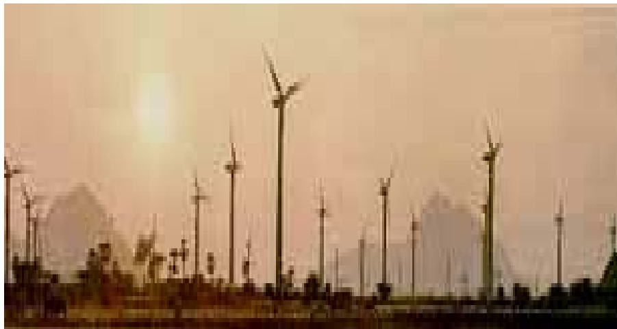
Fig. I.6 : Ferme éolienne de 10 MW dans la région de Tindouf [6]
