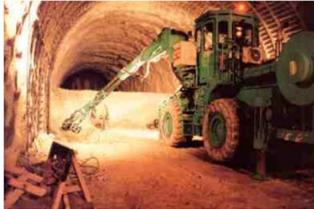
Fig.12. Creusement par demi- section.
