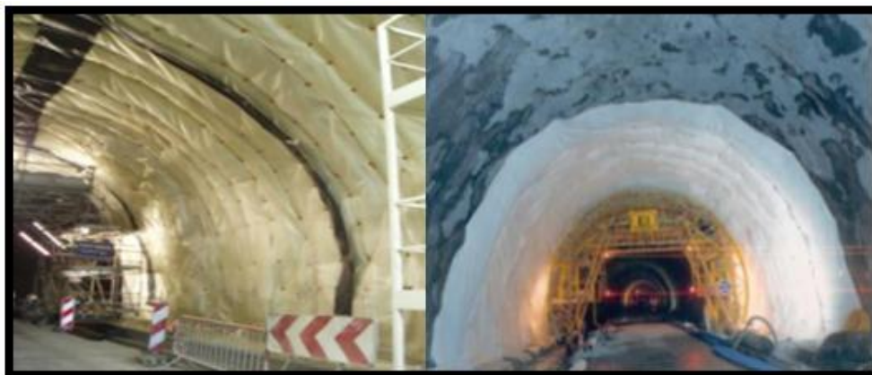
Fig.11. Etanchéité d'un tunnel.
