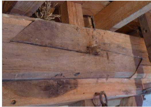
Figure 09: Image du trait de Jupiter en charpenterie [34]
