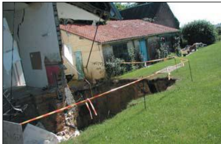
Fig.5.2 : Répercussions d'un affaissement de terrain sur des habitations
