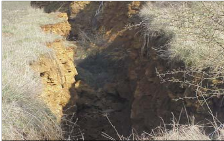
Fig.5.1 : Affaissement de terrain
