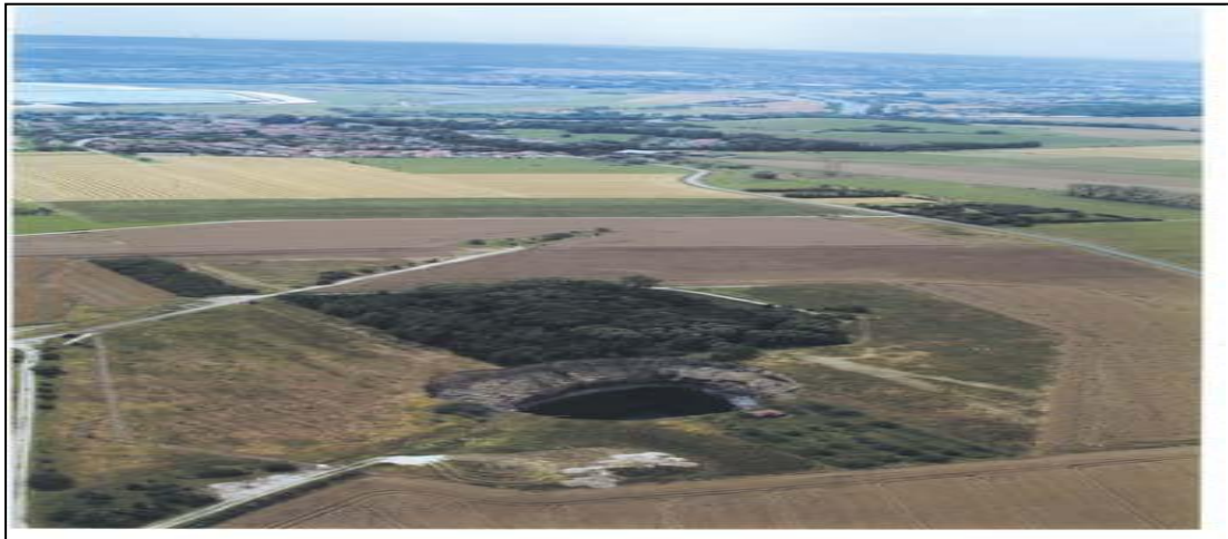
Fig.5.4 : Destruction d'un puits de mine source d'émanation des gaz
