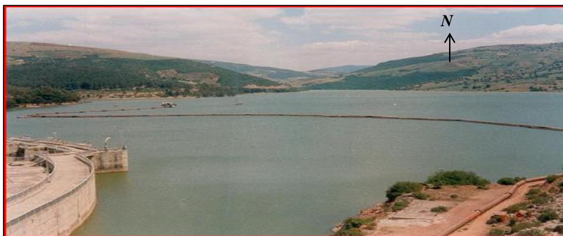
Fig n° 4.2: Photographie montrant une vue générale du barrage Zerdézas en période de dévasement.
