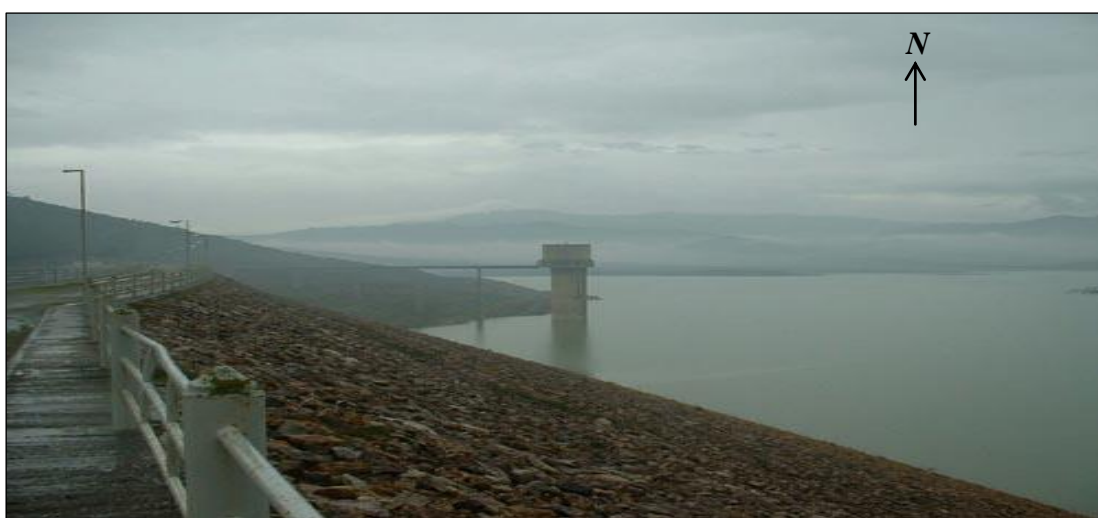
Fig n°4.3: Photographie du barrage Guenitra.
