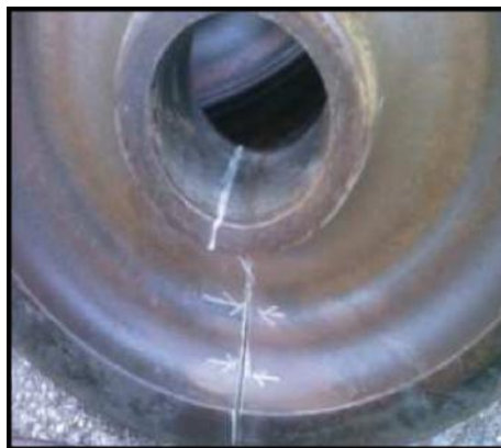
Figure 18 : rupture de la toile
