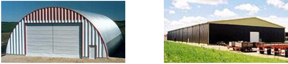
Fig. I-7 Bâtiment en acier pour usage agricole
