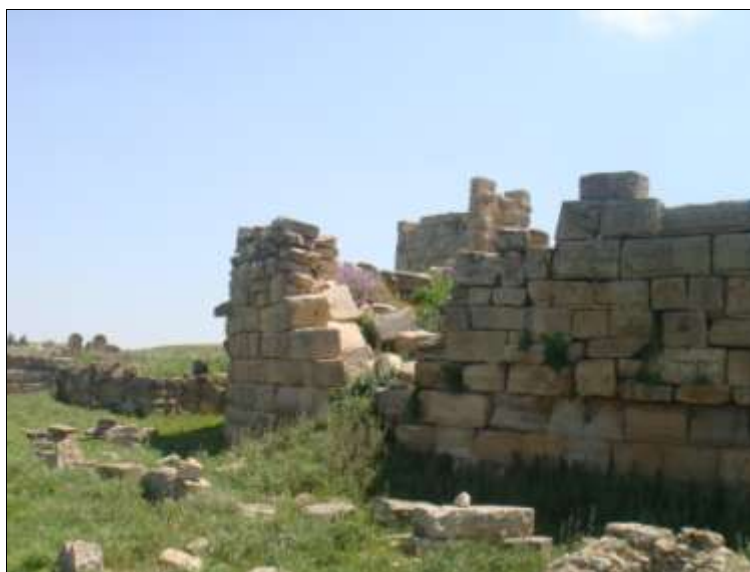
Photo 34 : Mur de soutènement des gradins du théâtre de Madaure, Source : auteur, avril 2010.
