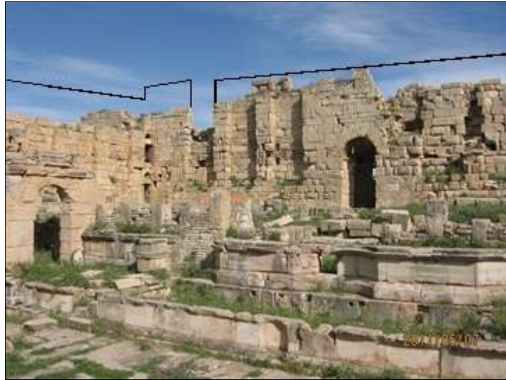
Photo 43 : Érosion des parties de la forteresse byzantine, Source : Auteur, Mai 2011
