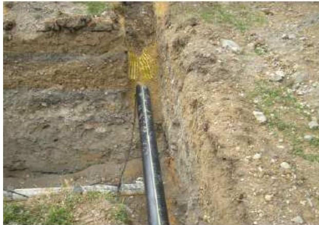
Figure IV.1 : Tube enfoui avec son backfill de terre [66].
