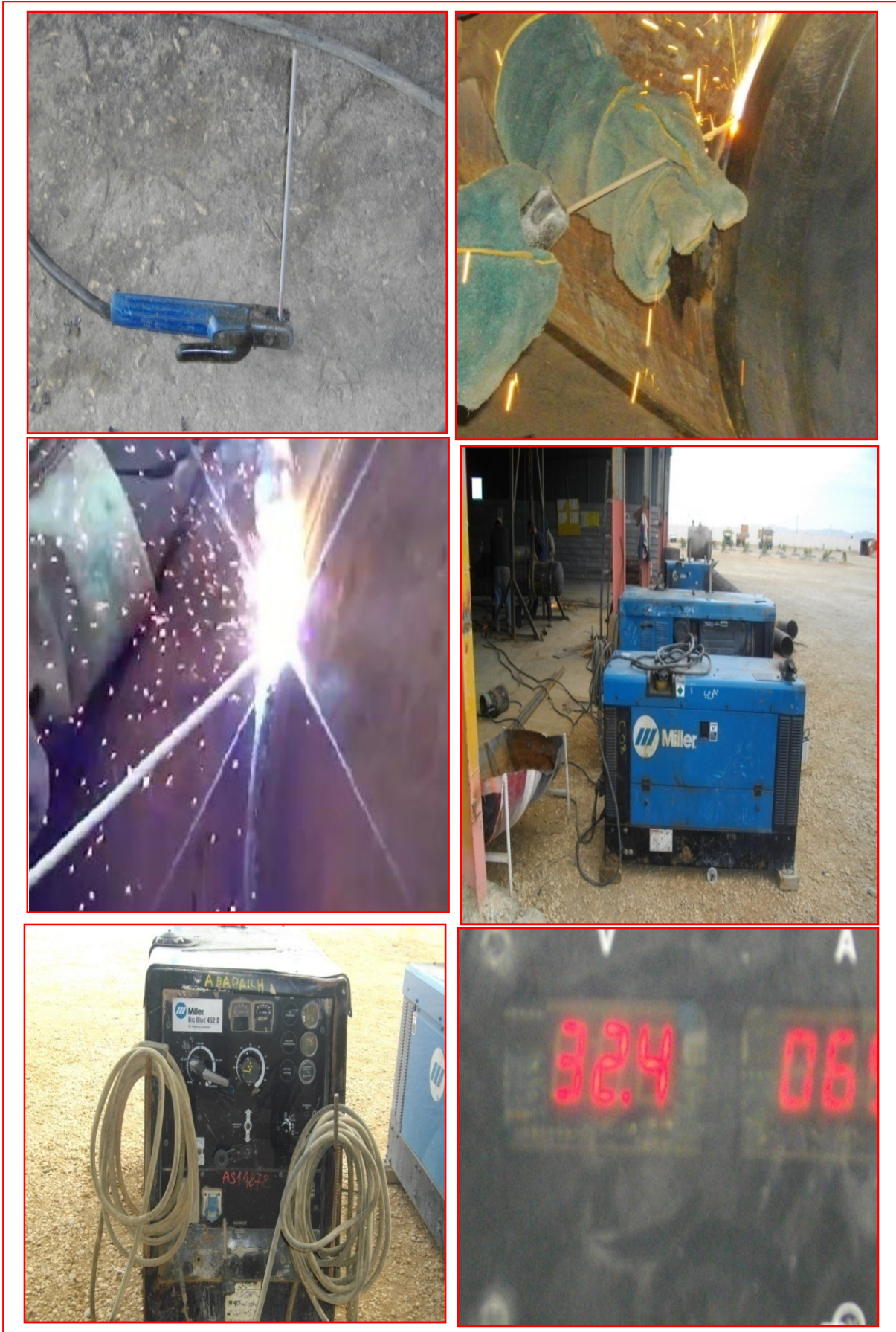
Figure II.2. Appareillage de soudage des pipelines au niveau de COSIDER.
