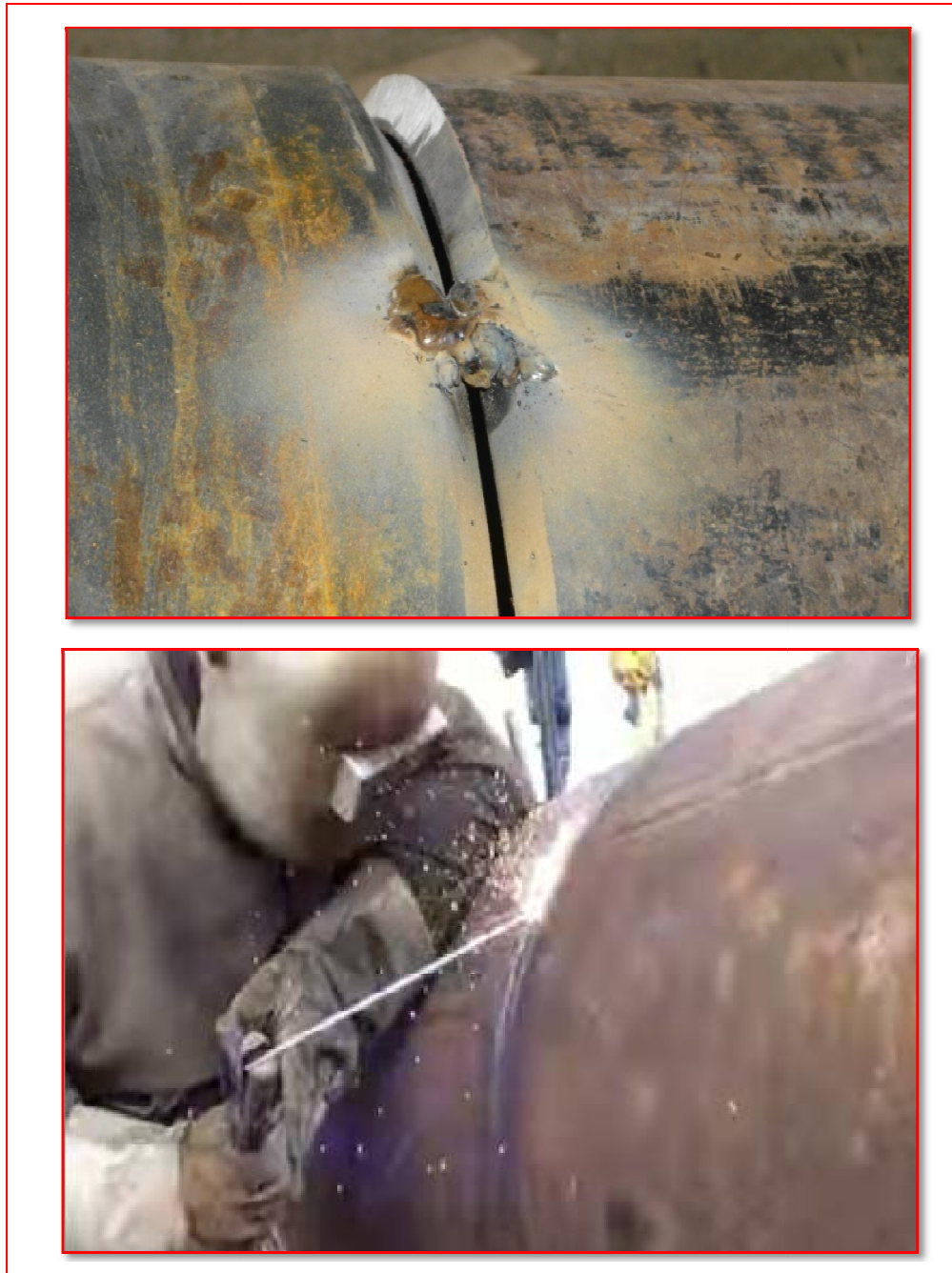
Figure II.1. Assemblages de deux tubes d'acier X42 pour le procédé de soudage à l'arc avec des électrodes enrobées (SMAW).
